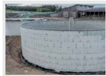
Runddämmung für Biogasanlagen.
