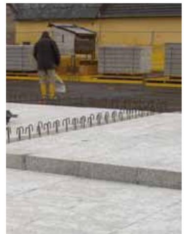
Die 3i-Dämmplatte eignet sich hervorragend für eine schnelle und saubere Verarbeitung. In die Schalung einlegen und ohne zusätzliche Befestigung betonieren. Durch die 3i Maßgenauigkeit vom **Nut- und Federsystem** ist eine exakte Verarbeitung möglich, Kältebrücken werden vermieden, sodass keine Energieverluste entstehen. .
