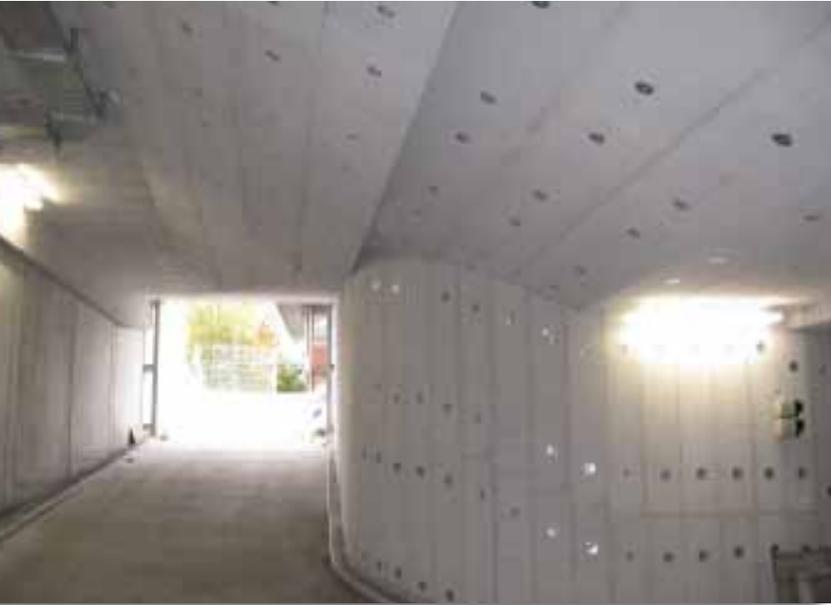
**Ideale Anwendung in Parkgaragen und Kellern zur Wärmedämmung und als Brandschutz.**
